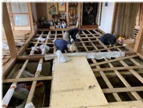
床下の泥かき作業の様子(大町町)
