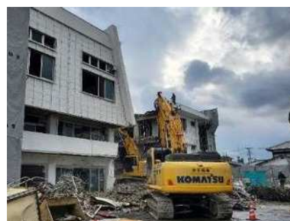
旧会館の解体工事
