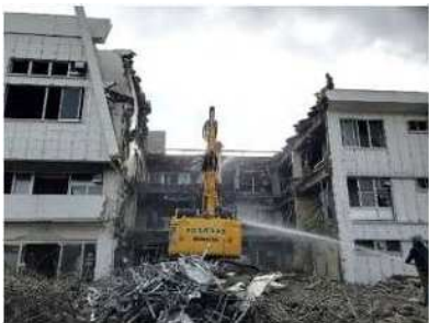
①重機による解体工事
