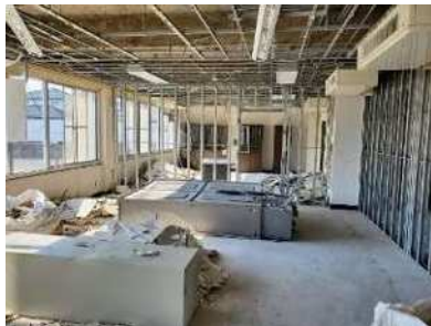
②会館内部解体
